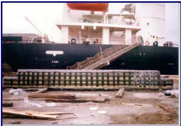
Рис.4. Бортовая балка в процессе наклейки углеродных лент.
