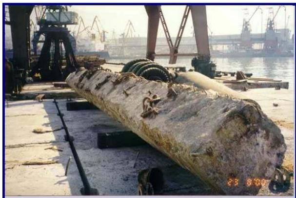
Рис. 2. Бортовая балка до ремонта.
